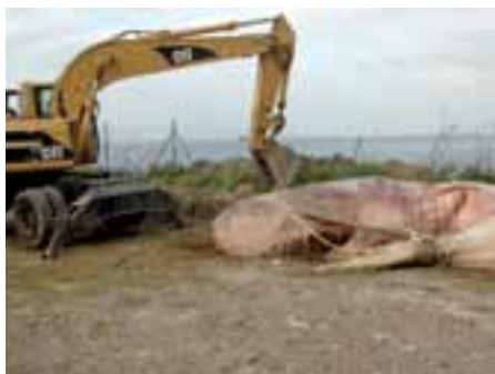
Últimos trabajos de depósito en el pudridero
