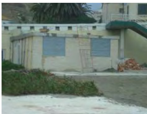
Estación actualmente reformada
