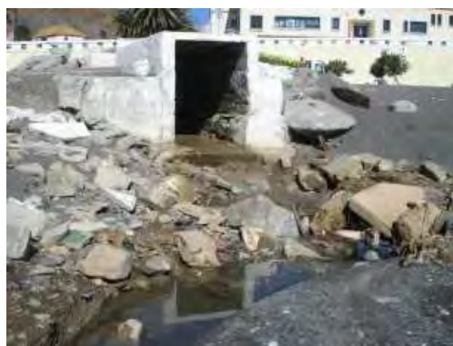
Salida del aliviadero (estación en reforma)
