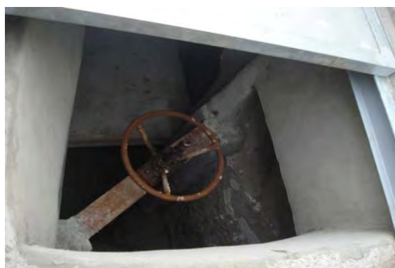
Parte interior de la estación de bombeo y válvula de compuerta del aliviadero Fotos tomadas el 26-02-2009
