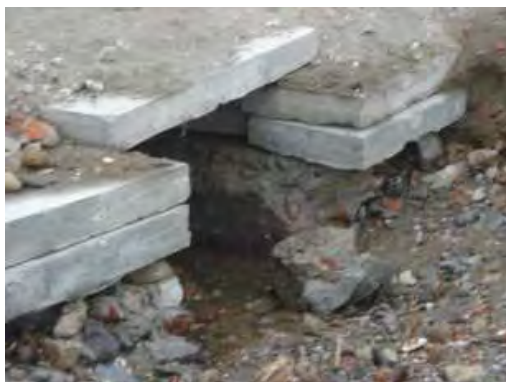
Foto tomada el 27-2-2009 Salida del aliviadero de la estación.
