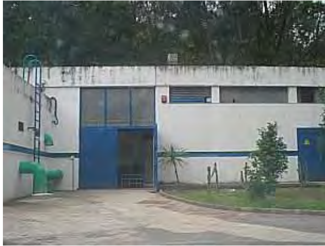
Estación de impulsión de la ETAP. Fuente propia.
